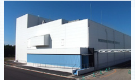
高濃度アルコール製剤対応製造棟(富山工場)
