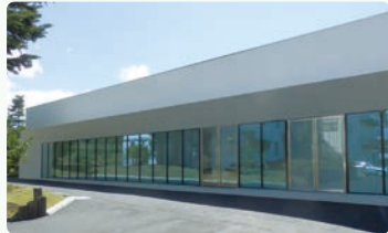
バイオリサーチセンター(山梨)
