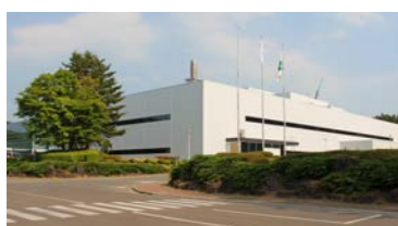
西根工場外観
