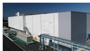
足利工場新注射剤棟 高薬理活性剤(抗がん剤など)の最新設備
