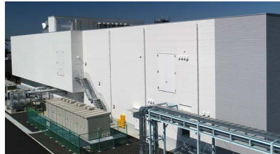
足利工場新注射剤棟 高薬理活性剤(抗がん剤など)の最新設備
